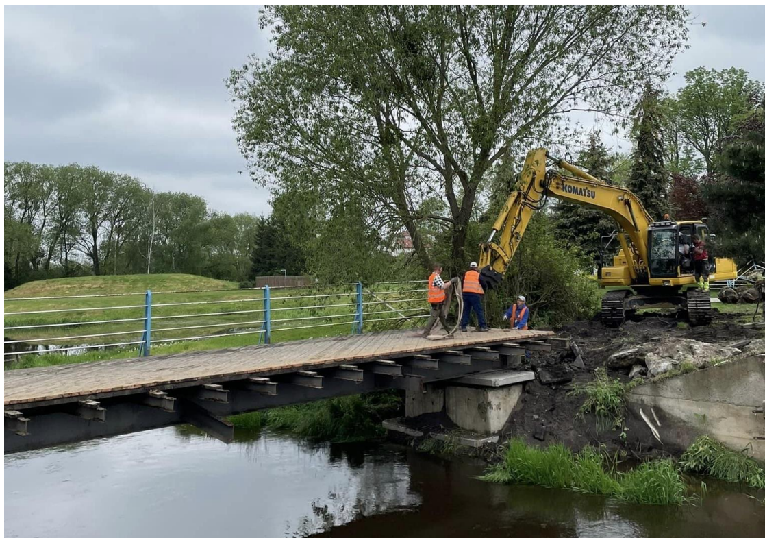
Zdjęcie nr 20. Rozbiórka istniejącego mostu
