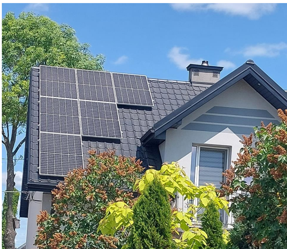
Zdjęcie nr 4. Panele fotowoltaiczne na budynku prywatnym
