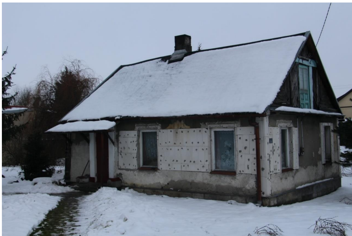
Zdjęcie nr 7. Budynek socjalny w Wisznicach
