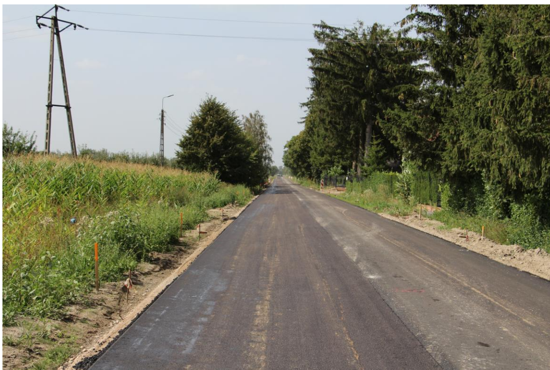
Zdjęcie nr 18. odcinek drogi Polubicze Wiejskie - Horodyszcze z nową nawierzchnią
