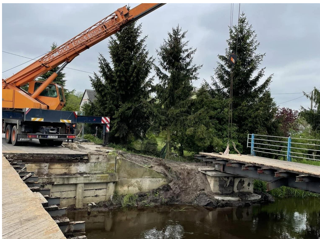
Zdjęcie nr 21. Przygotowania do budowy nowego mostu przez rzekę Zielawę
