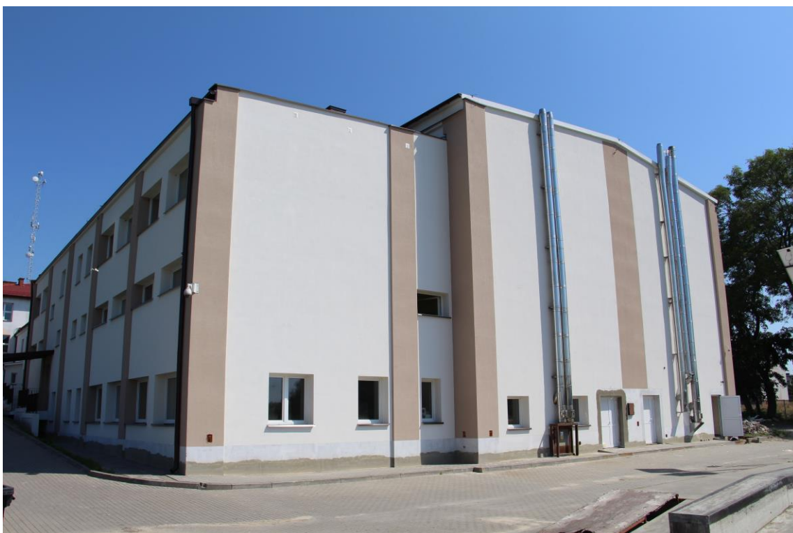
Zdjęcie nr 15. Budynek Szkoły Podstawowej w Wisznicach po termomodernizacji
