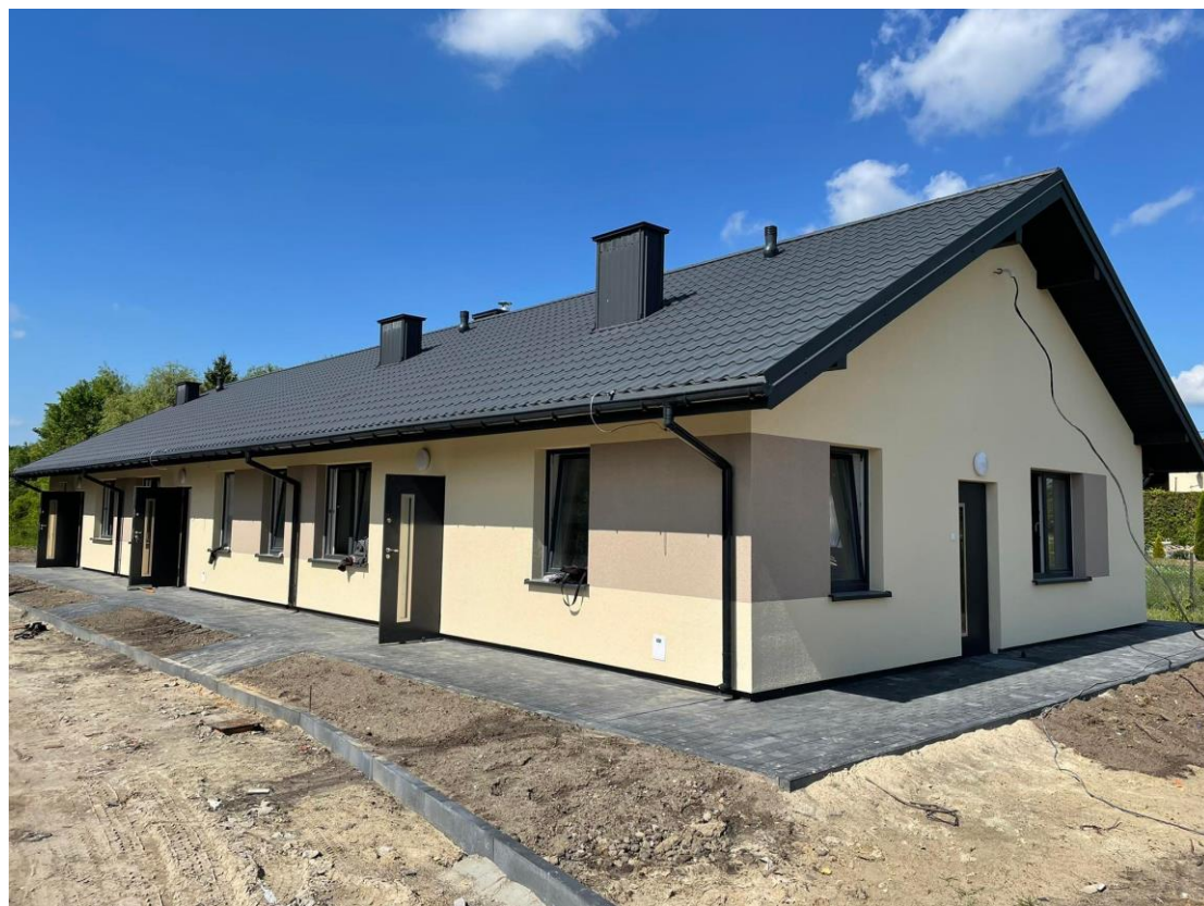
Zdjęcie nr 8. Nowy budynek z mieszkaniami socjalnymi w Wisznicach
