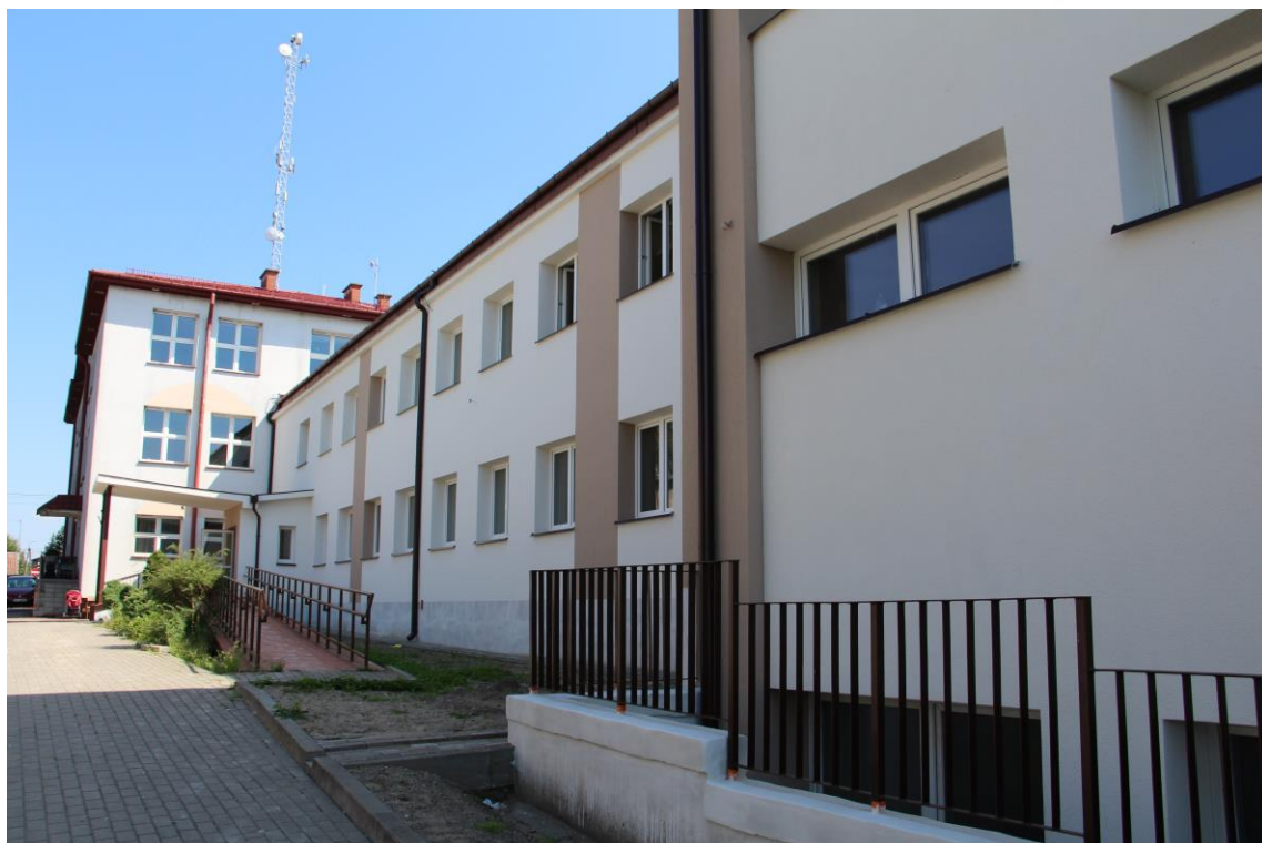
Zdjęcie nr 14. Budynek Szkoły Podstawowej w Wisznicach po termomodernizacji
