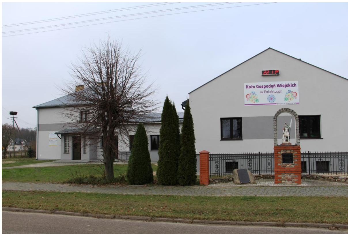
Zdjęcie nr 13. Budynek Świetlicy Wiejskiej w Polubiczach po remoncie i termomodernizacji
